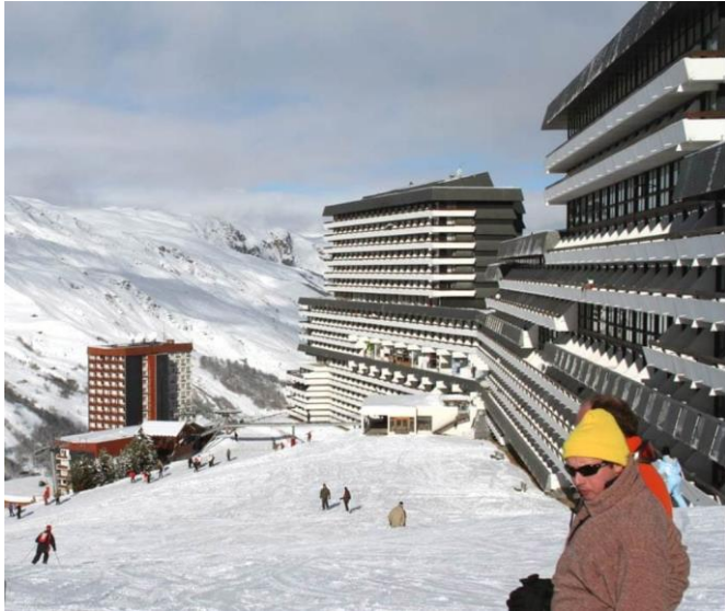
Рисунок 6. Общий вид фрагмента застройки горнолыжного центра Бельвиль (Франция). Арх. Кандилис
